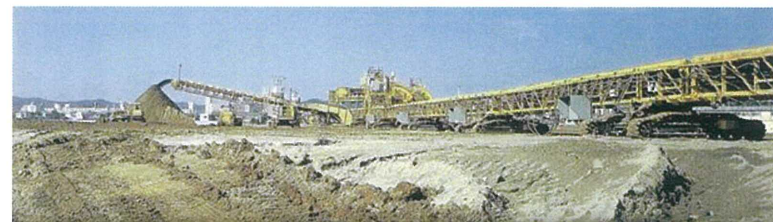
東亜建設(株) 様（海の公園 埋立工事）
